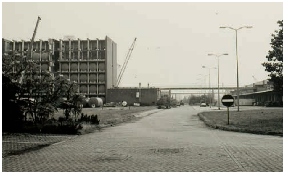
Het 'keldergebouw' tijdens de afbraak in 1984. Duidelijk te zien zijn de afzonderlijke dichte tanks. (foto Leo van der Zanden, collectie RHCE)
