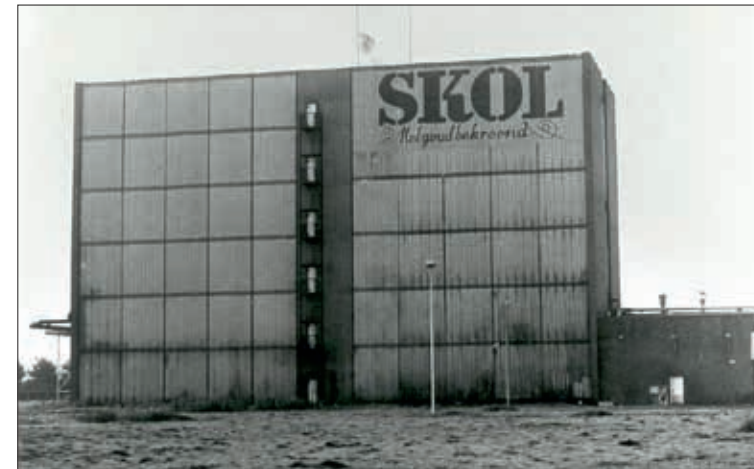
Het 'keldergebouw' gezien vanuit de richting van de rotonde aan de Engelseweg. (foto Leo van der Zanden, collectie RHCE)
